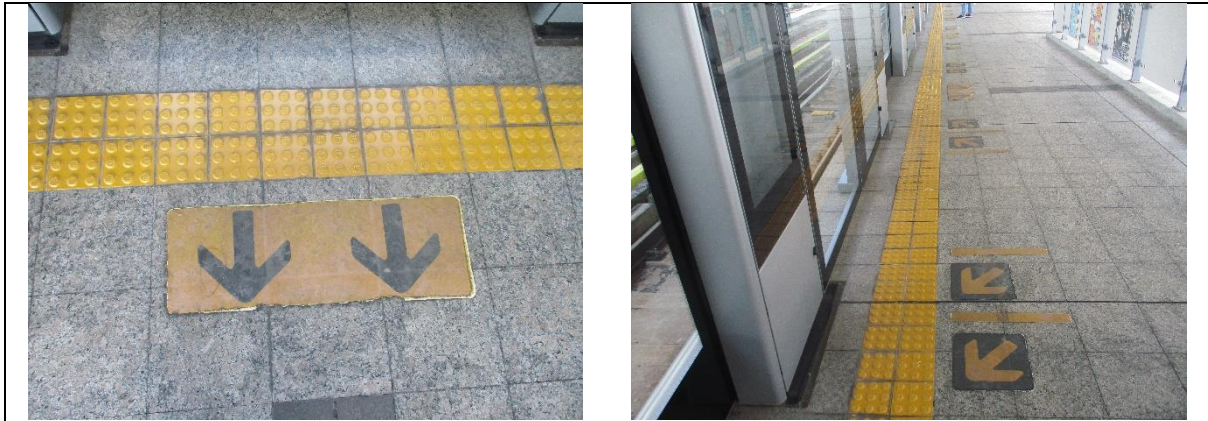
รูปที่ 2-20 (ต่อ) แนวเส้นสีเหลืองและพื้นผิวขรุขระแสดงเขตห้ามลงล้อ
