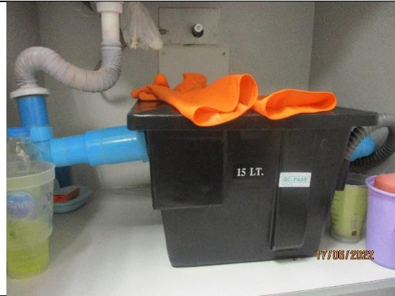
รูปที่ 2-1 การติดตั้งถังดักไขมันในห้องพักพนักงาน
