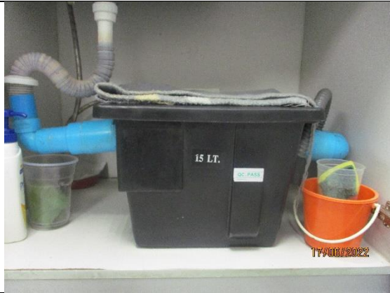
รูปที่ 2-1 การติดตั้งถังดักไขมันในห้องพักพนักงาน
