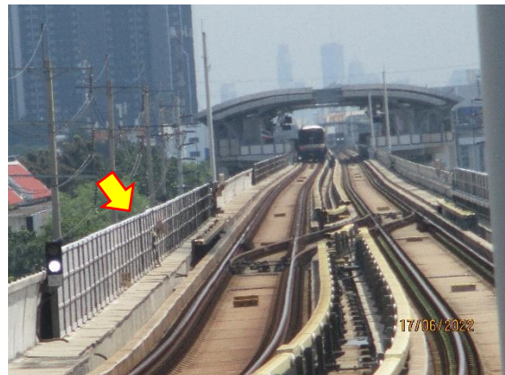
รูปที่ 2-3 ติดตั้งกำแพงกันเสียงสูง 1.20 เมตร ตลอดสองข้างทางของรางรถไฟฟ้า
